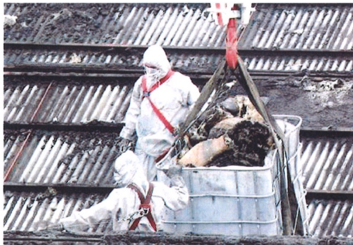
Tecnici al lavoro per lo smaltimento in sicurezza di lastre di cemento amianto su un tetto
